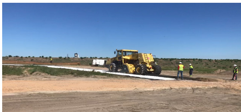
Demostradores de secciones de carretera que incorporan los residuos susceptibles de valorización.
