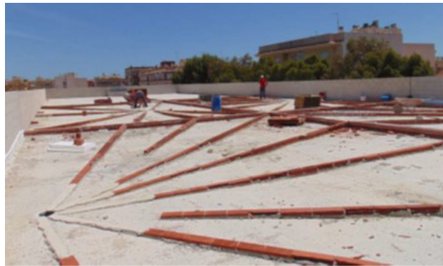
Primeras reuniones en obra y planteamiento de primeras unidades de obra más (albañilería).
